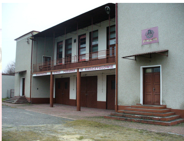
Budynek OSP w Kiełczygłowie
